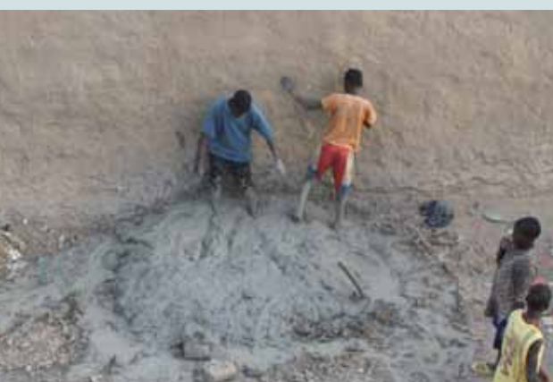
Talibé kinderen in Djenné trappen de leem dagenlang fijn voor hij de goede kwaliteit heeft om te gebruiken voor de restauratie van de grote moskee
